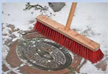
Unter diesem, in der Fahrbahn oder Gehweg eingelassenen Metalldeckel, befindet sich die Löschwasserentnahmestelle der Feuerwehr, dem sogenannten Hydranten
