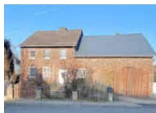
Boden: Zweifamilienhaus mit Scheune und Anbau, Wfl. ca. 190 m 2 , Grdst. ca. 1.150 m 2 , 5 Zi.
