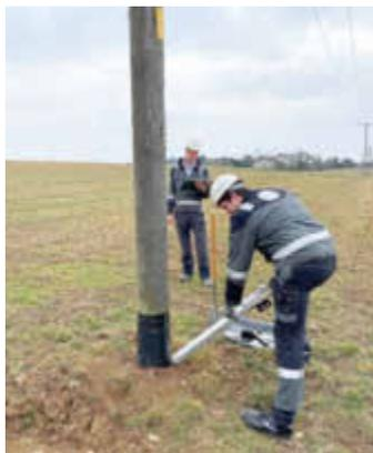
zum Schutz gegen vorzeitige Fäulnis mit neuen Mastbandagen im Erdübergangsbereich versehen. Auf Dauer nicht mehr standfeste Masten werden durch neue Masten ersetzt. Im Zuge der Holzmastkontrolle wird auch eine Inspektion und Sichtkontrolle der Niederspannungsfreileitung einschließlich der Dachständer durchgeführt.
