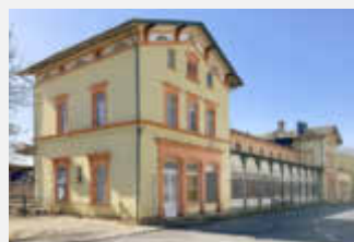
Diez: Bahnhofgebäude im spät-klassizistischen Baustil, Gesamtfl. ca. 2.555 m 2
