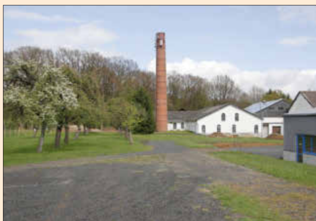
Die Gebäude der Grube Petersbach (Eichelhardt) sind bis heute erhalten geblieben. In den ehemaligen Tagesanlagen befindet sich ein metallverarbeitender Betrieb. Weitere Infos zu eines der tiefsten Bergwerke im Westerwald unter QRKultur ( www.qtr.de/prka0032 ). Foto: www.montomedia.de
