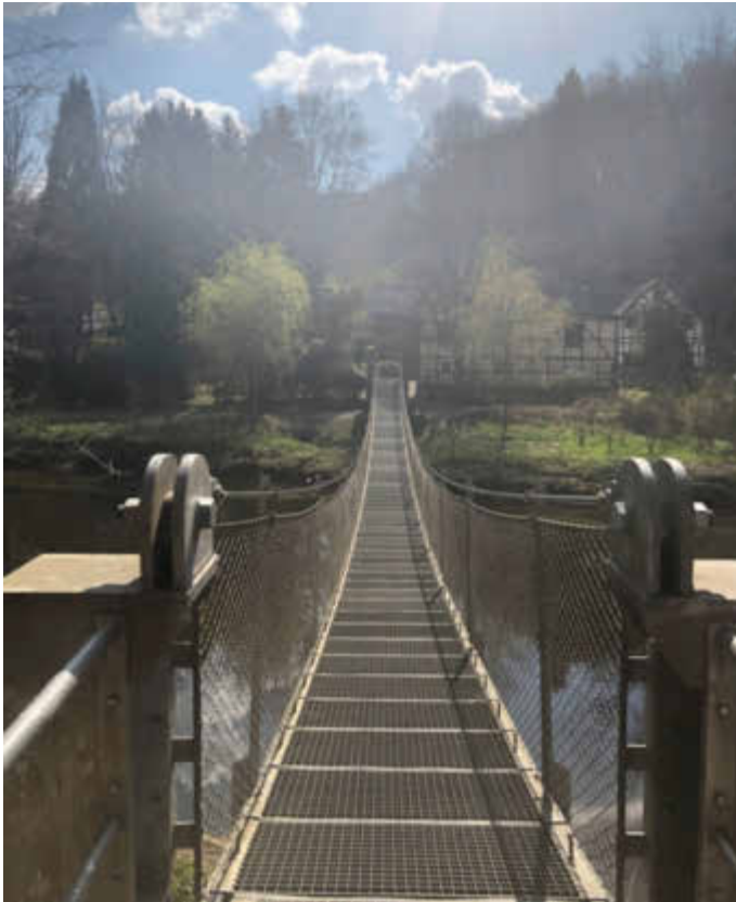
Seilhängebrücke mit Blick auf die Mühle
