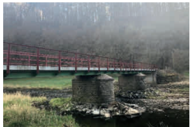
Sanierte Brücke zwischen Helmeroth und Eng
