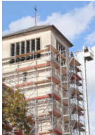
Eingerüstet erwartet die katholische Kirche St. Jakobus in Altenkirchen eine Reihe von Renovierungsmaßnahmen Foto: H.-G. Augst
