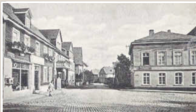
Blick in die Frankfurter Straße, die ab 1927 Mackensen Straße hieß
