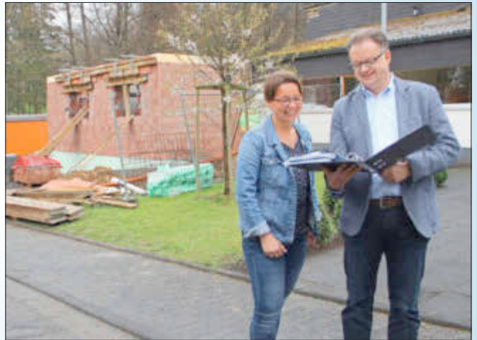
Die Generalsanierung mit Anbau an die Kita „Burgwiese“ in Mehren liegen laut Sascha Koch, Fachbereichsleiter Soziales und Generationen von der VG-Altenkirchen, voll im Plan. Zusammen mit Kita-Leiterin Sandra Kanthak besichtigte Koch die Bildungseinrichtung. Foto: Heinz-Günter Augst
