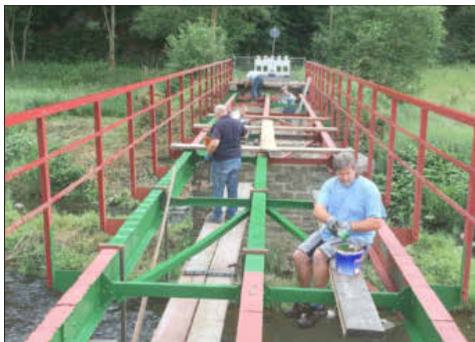
Seit 25. Mai restaurieren viele fleißige Hände die Fahrbrücke über die Nister in Helmeroth.
