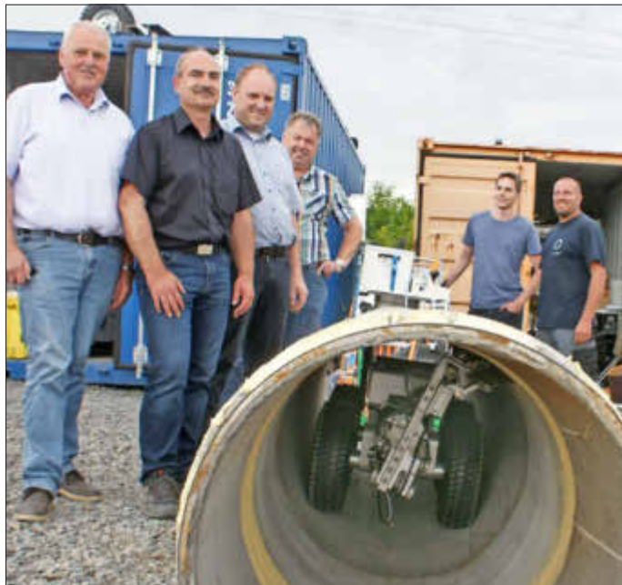
Von links: WKA Baustellenleiter Wassermeister Karl-Horst Stark, Projektleiter Rohrtechnik, Ingo Prinz aus St. Ingbert, Ulf Heinemann vom Ingenieurbüro aus Altenkirchen und Michael Wisser, Projektleiter der Fa. Robert Schmidt aus Müschenbach; rechts im Bild: Holger Müller und Marco Prinz, zuständig für die Technik
