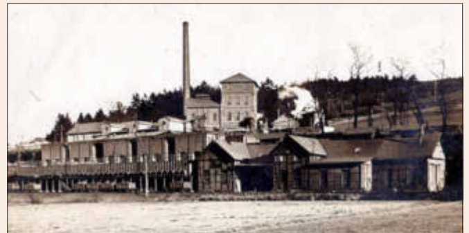
Grube Louise (etwa 1925); Auf dem Foto sind die Röstöfen für Spateisenstein auf der Etage unterhalb des großen Gebäudes (große Öffnungen) mit Bahnverladung über dem Erzbunker zu sehen. Ebenso der Backsteinfördererturm des Barbara-Schachtes. Foto: Archiv Albert Schäfer
